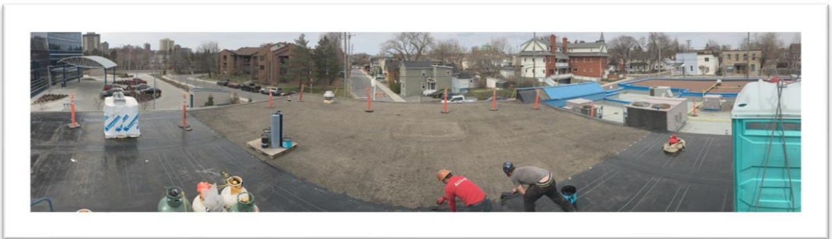
PHOTO 4 : LE TOIT EST PRESQUE TERMINÉ.
