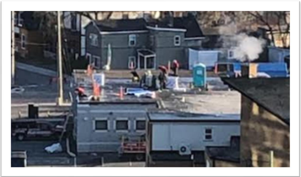
PHOTO 3 : ON CONTINUE LES RÉNOVATIONS DU TOIT.
